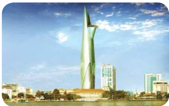
Tòa nhà tài chính Bitexco
