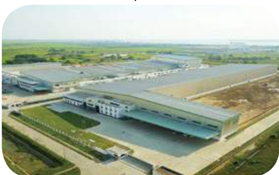
Nhà máy Boxpak - Myanmar
