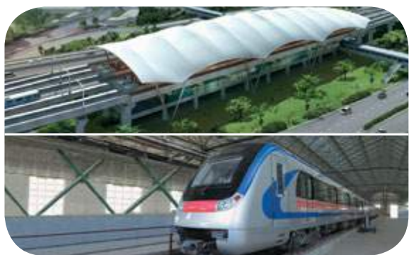
Tuyến đường sắt đô thị Metro (Bến Thành - Suối Tiên) Tuyến đường sắt đô thị Metro (Nhổn - Ga Hà Nội)
