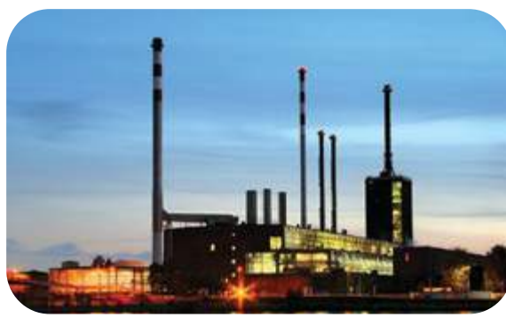
Nhà máy nhiệt điện Thái Bình - Thái Bình
